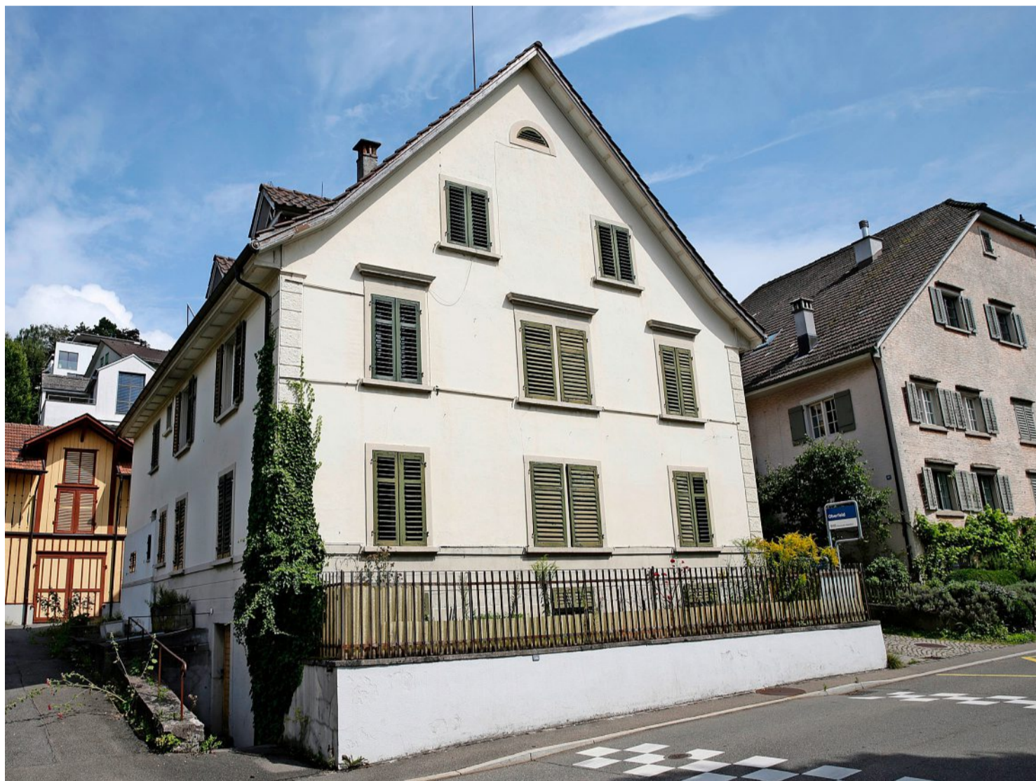
Das Wohnhaus an der Oberen Heslibachstrasse 45 ist in die Jahre gekommen: Küchen, Nasszellen und die haustechnischen Anlagen sind in sehr schlechtem Zustand. Rechts der etwa aus dem Jahr 1500 stammende gotische Klosterspeicher. Foto: Moritz Hager
